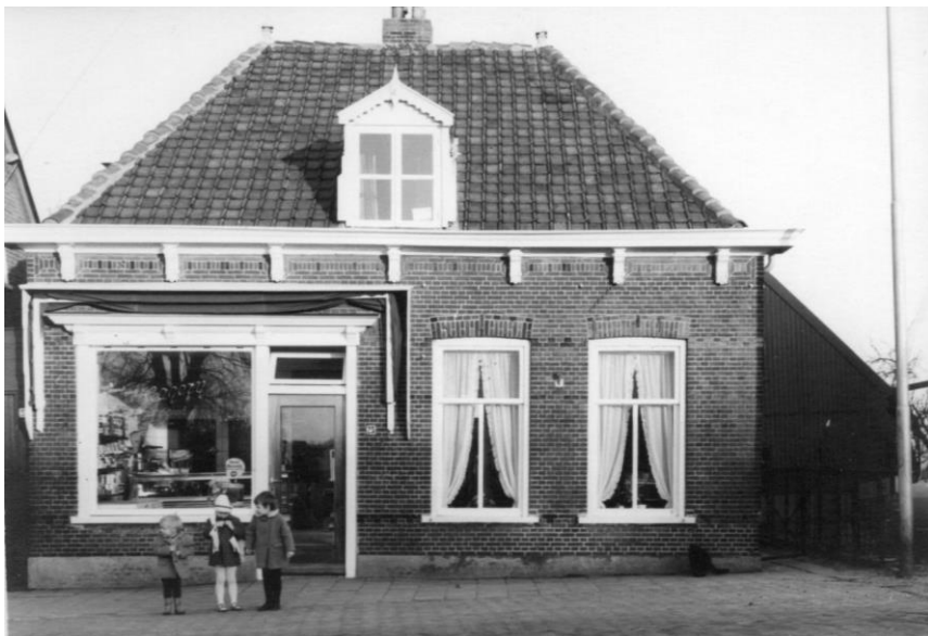
De oude slagerij van Piet en later Anton van der Geest, Pastoor van der Plaatstraat 25, Rijpwetering, in 1971. Links de winkel, rechts het woongedeelte. Uiterst rechts de schuur van Jac van de Bosch. Vóór, links dochtertje Yvonne en twee vriendinnetjes.
