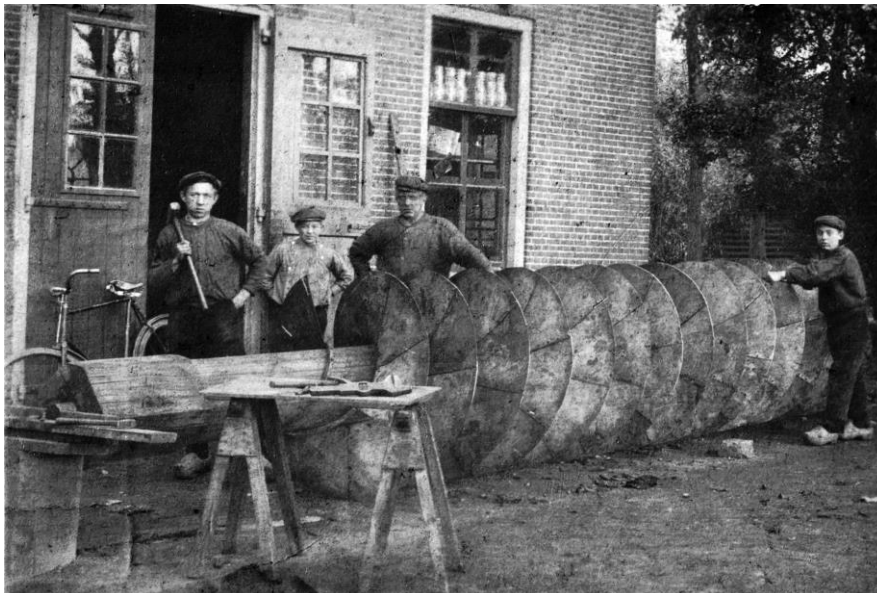
Smid Jan Waasdorp in 1912, bij het repareren of verlengen van een vijzel voor een van de vele molens in de omgeving. Verlenging was soms nodig vanwege het inklinken van de polder. Van links naar rechts: Bert Waasdorp, Arie Heemskerk (buurjongen), Jan Waasdorp sr, en Jan Waasdorp jr (broer van Bert). (Met dank aan Roen van der Geest)
