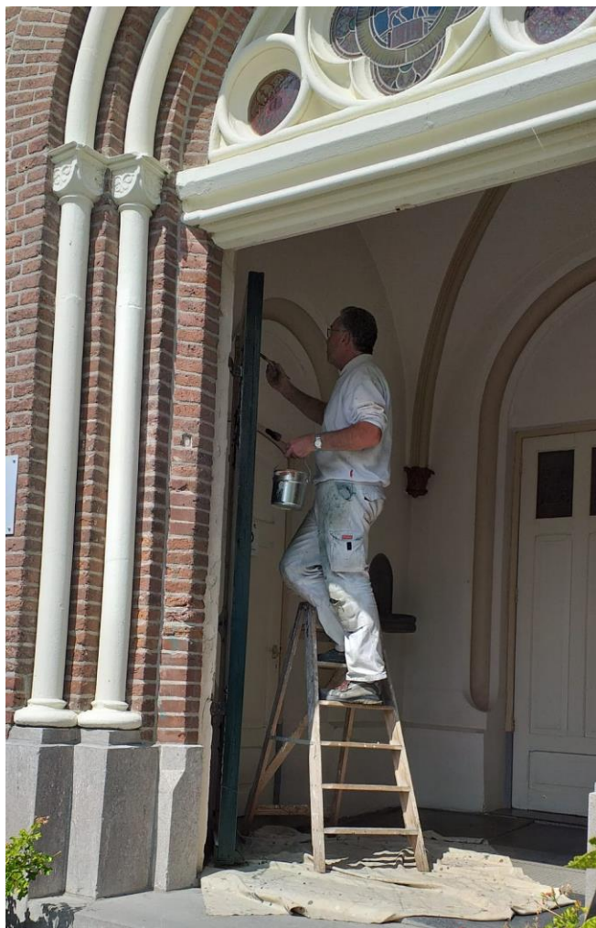
Antonie aan het werk in het portaal van de kerk in Oud-Ade
