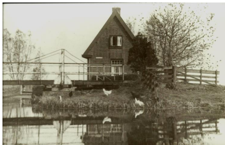
Brugwachterswoning, Veenderdijk 1, sluis en voetbrug tegenover de Zwanenbrug. Onbekend wanneer.
